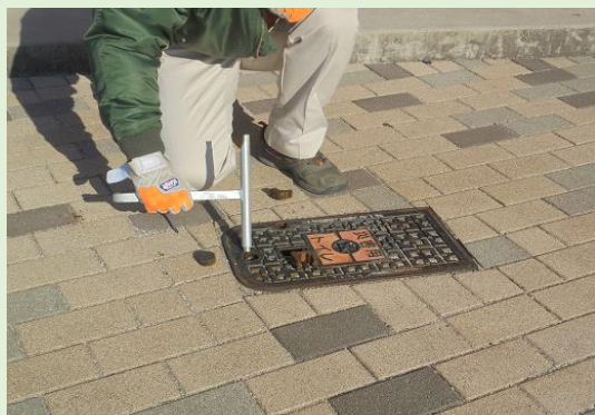
マンホールの蓋を開ける。
