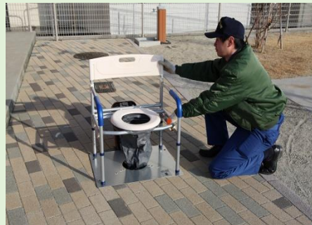
便器を設置する。カバーは確実に穴の中へ入れる。
