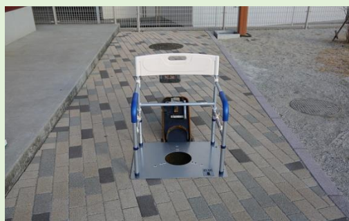
プレートの上に椅子を設置します。
